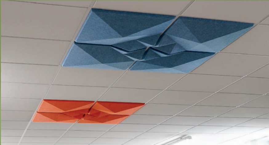
Sternförmig verformte Einleger für Rasterdecke
